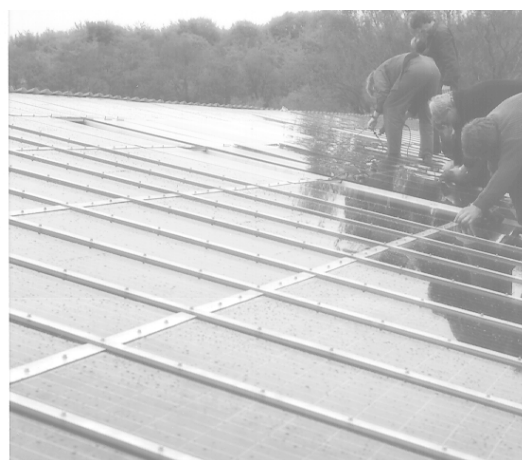
Bild 3: Bau der Solaranlage als Dachintegration auf der Südseite des DAUG Werkstattgebäudes in Zirkow
